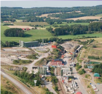
Hallandsåstunneln kommer att färdigställas under år 2015.
