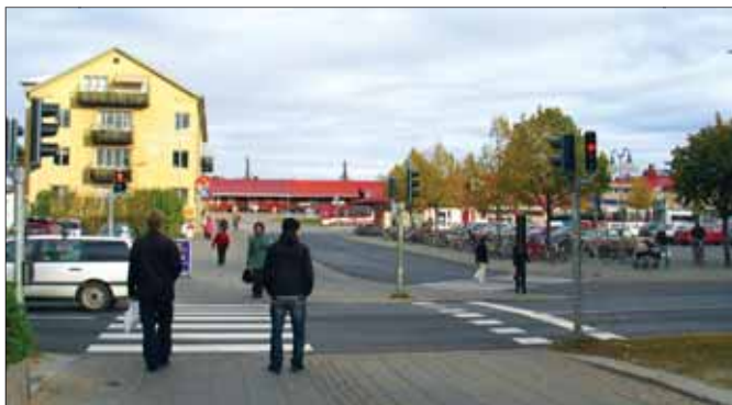
Nuvarande busstationsområde i Skellefteå sett från söder. Det är angeläget att skapa ett attraktivt stråk mellan resecentrum och stadscentrum.
